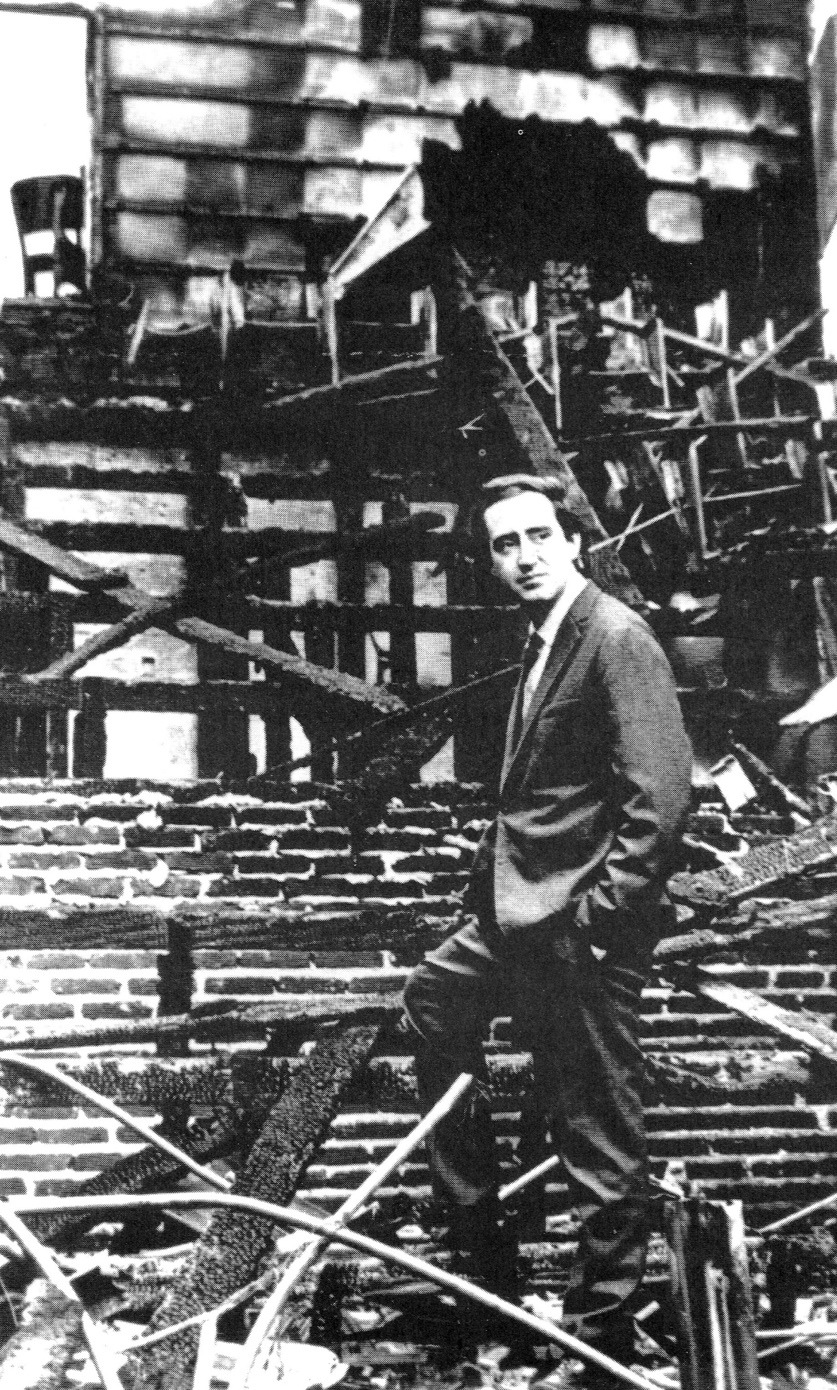
À esquerda, Zé Celso nas ruínas do Teatro Oficina, após o incêndio de 1966. Abaixo, croqui de Lina Bo Bardi. À direita, Teatro Estádio, foto de Renato Mangolin.
